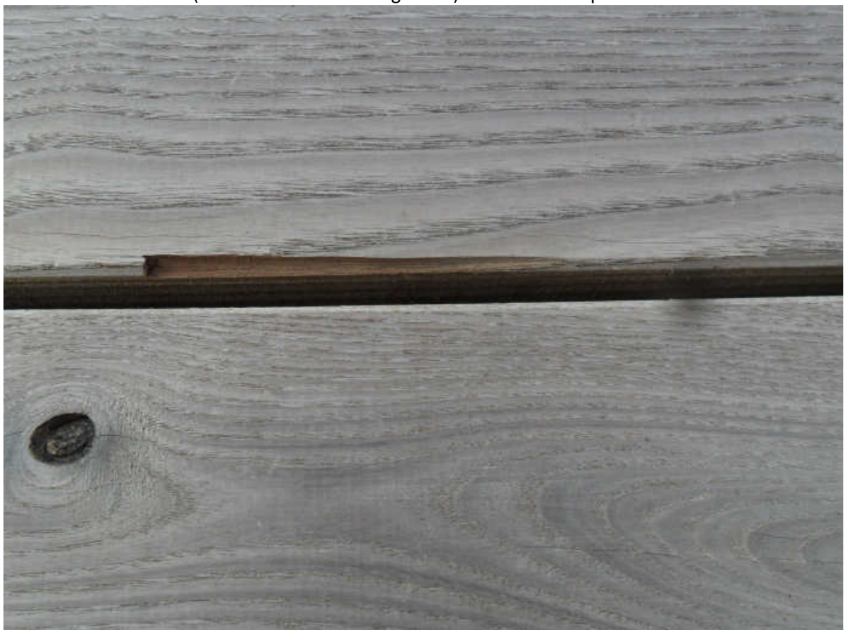
Spreißelbildung an der Kante (nicht aufstehend) -> muss akzeptiert werden
