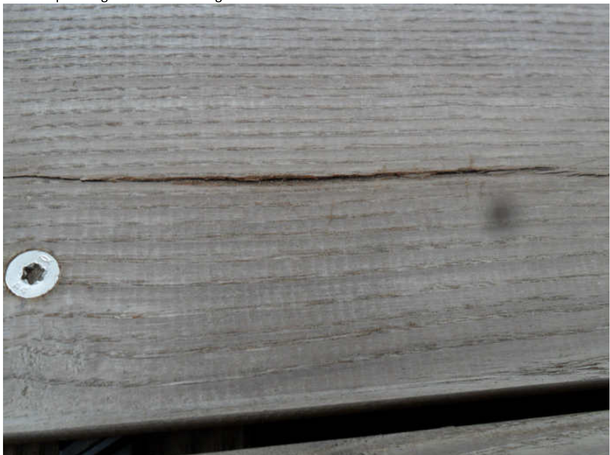
Schieferbildung (steht nach Bewitterung ca. 1 mm auf) → Holzspindel mechanisch glätten
